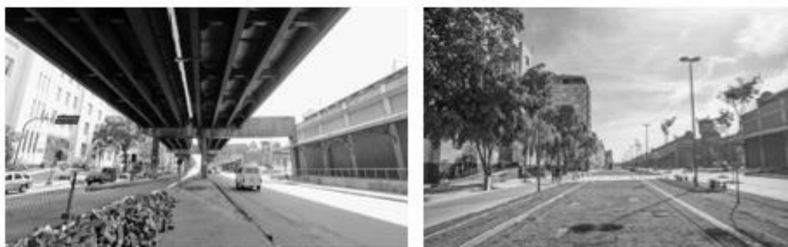
Fig. 8-9 – os “novos” espaços urbanos adjacentes – o antigo Viaduto da Perimetral (à esquerda) e o Boulevard Olímpico (à direita)
